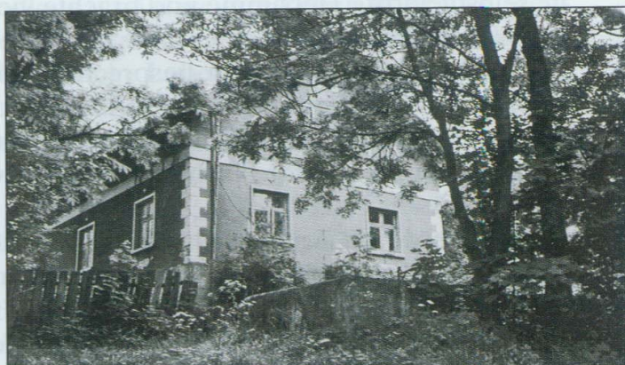
Das Haus Schemmerling wurde später verputzt. Es stand im Jahr 2000 noch (s. o.). Inzwischen ist es gänzlich abgebrochen. Foto: A. Motzkus
