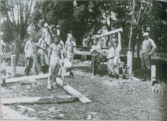
Pioniere 1937 beim Bau der Brücke zwischen Muldszen und Schemblonen. Foto erhalten von Helga Schur (geb. Bendick), Dorfstr. 17, 15324 Neubarnim
