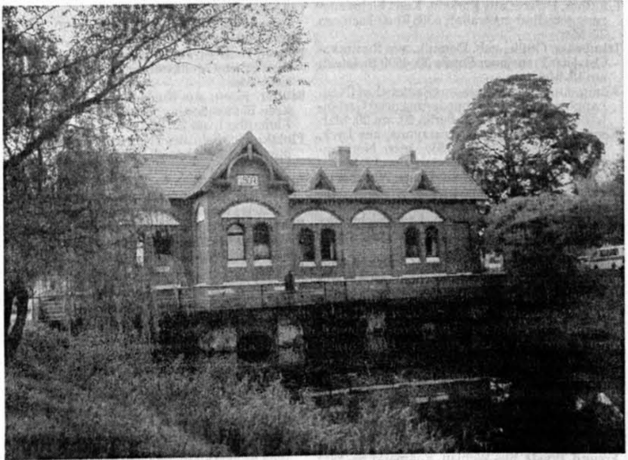
Hebewerk Dumbelwiesen: Das Gebäude aus dem Jahr 1907
