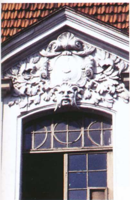
326 Detail des Giebels über dem Treppenhaus des Hauses Nr. 39
