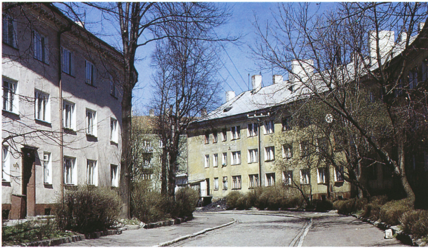
352 Wohnanlage Dornstr. / Hammerweg Ansicht Der Häuser Dornstraße ab Nr. 3 (linke Seite) und ab Nr. 2 (rechte Seite)
