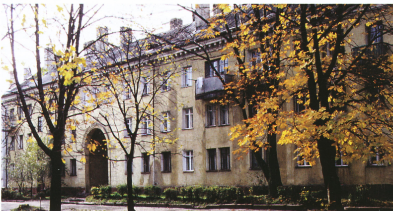
353 Wohnanlage Krausallee / Hammerweg Ansicht Der Häuser Krausallee von Nordosten
