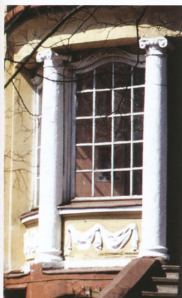
372 Ansicht der Fenster im Wintergarten mit der Säulenstellung
