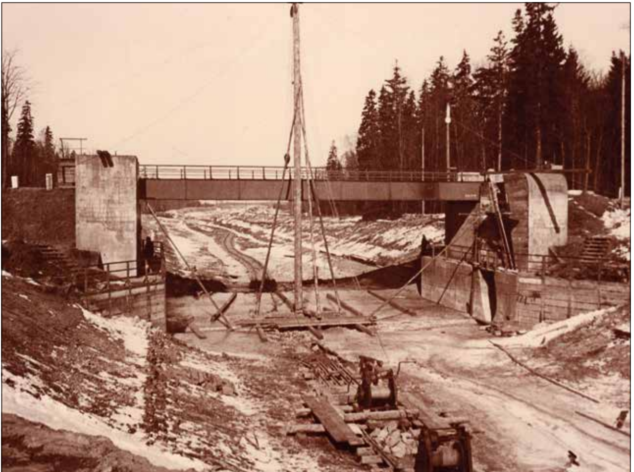
Bild 7: Fertiger Kanalaushub 2,6 Kilometer südöstlich der Schleuse Georgenfelde beim Sicherheitstor Nr. 1.
