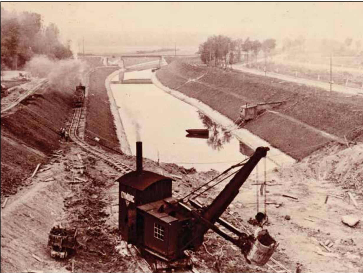
Bild 5: Baggararbeiten am Unterhaupt der Schleuse Georgenfelde im Jahre 1937. Auftraggeber: Bauamt für den Masurischen Kanal, Insterburg.
