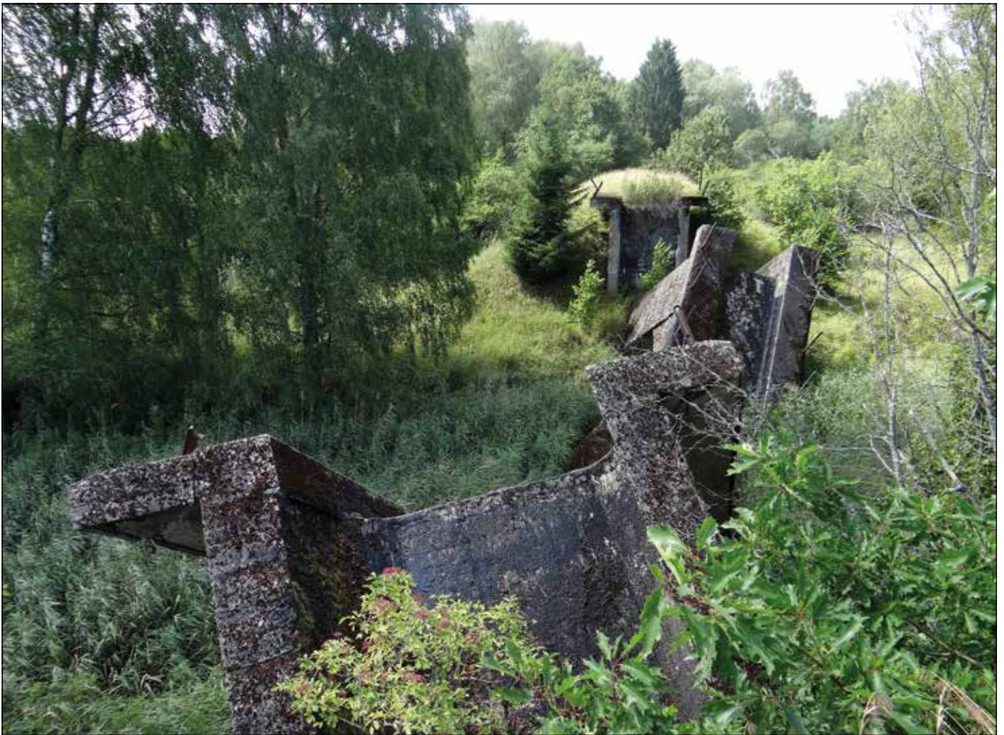
Bild 13: Überreste der Eisenbahnbrücke auf der einstigen Linie Nordenburg–Skandau.
