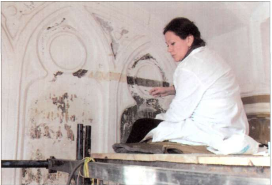
Mit großer Sorgfalt werden die Dekors restauriert.
