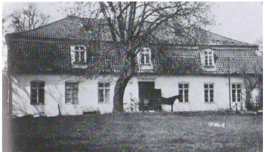
Gutshaus Gr. Klitten
