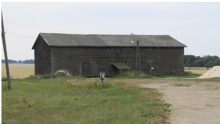
Scheune im Bereich der ehemaligen Stellmacherei
