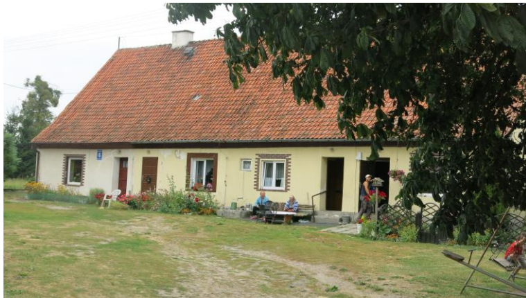
Das ehemalige Kämmererhaus mit 4 Wohnungen befindet sich in einem guten Zustand.
