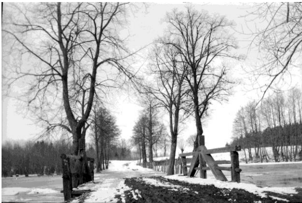
Brücke über die Doste während der Schneeschmelze 03.1931 (19)
