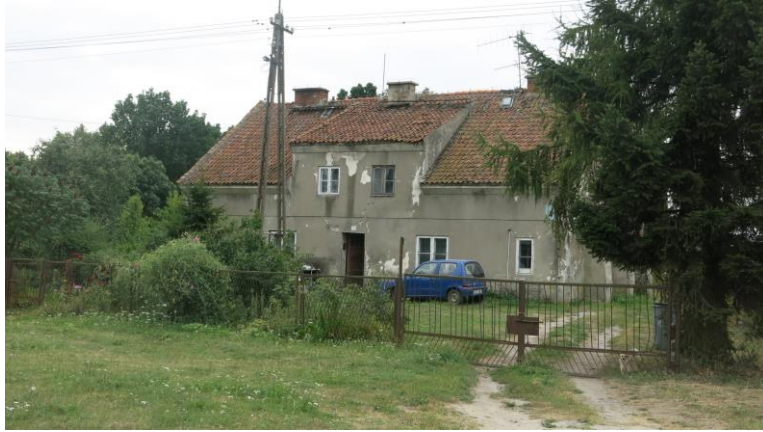
Das einstige Wohnhaus der Familien Schwarz und Tischka befindet sich in einem äußerlich schlechten Zustand.
