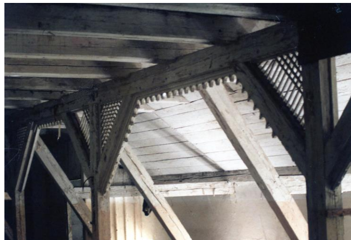
Dachboden des Gutshauses 2007 (7)
