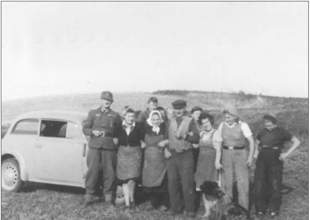
Kaffeepause - gleichzeitig Besichtigung der Notbrücke über die Aschwöne zwischen Bergenthal und Friedenshof, vom Militär aus Holzbohlen gebaut -im Oktober 1944
