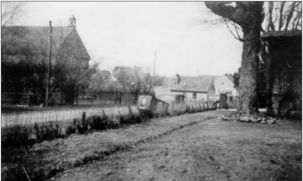
Kubstall (links), Gutsbaus (rechts), Schmiede, rechts davon ein Leutehaus, links oben die zwei neuen Leutehäuser
