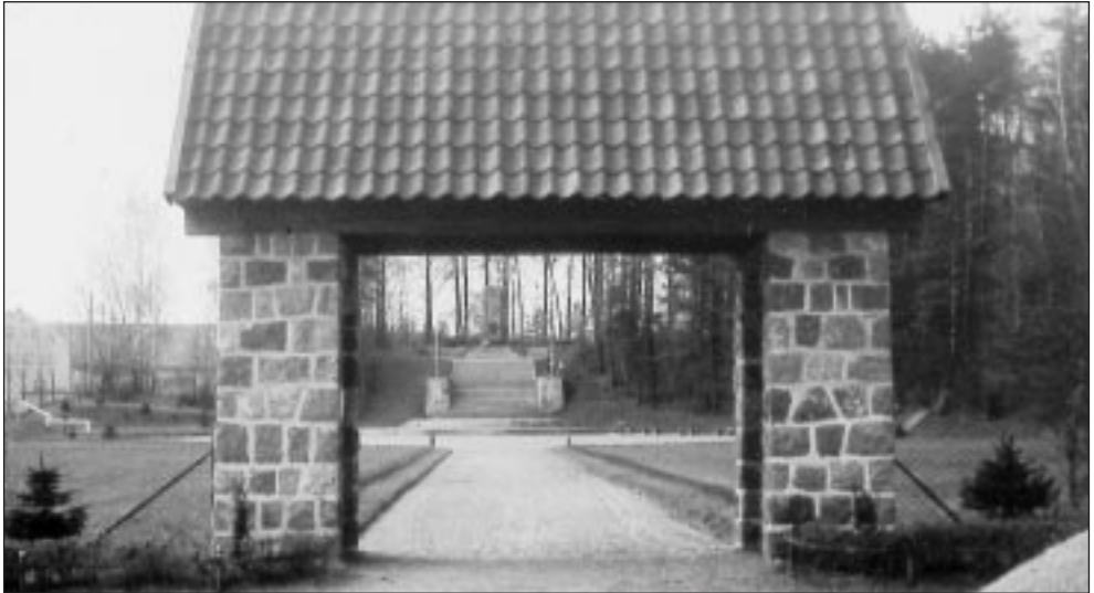
Der Tingplatz, links im Hintergrund das Schützenhaus
