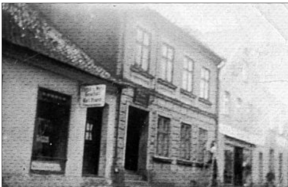
Bergstraße 79, Haus Landecker mit Essigfabrik
