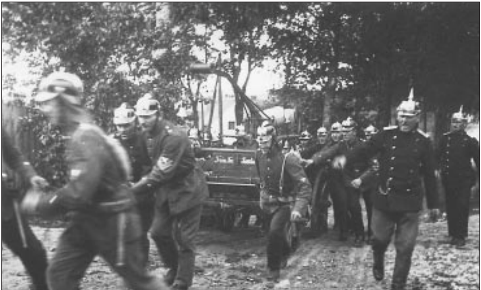
Übungslöschangriff auf das Geböft Lukenbach an der Reichsstraße 131. Im Hintergrund rechts steht das Spritzenhaus, rechts neben dem Baum das Kriegerdenkmal.
