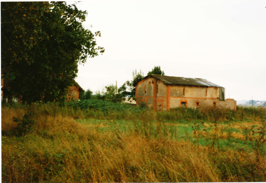
Aufnahme 4/31 vom 21.09.1991: Rüttelsdorf (Neu Pillkallen). Stallgebäude vom Anwesen Walter Gerlach, dem letzten Bürgermeister von Rüttelsdorf.
